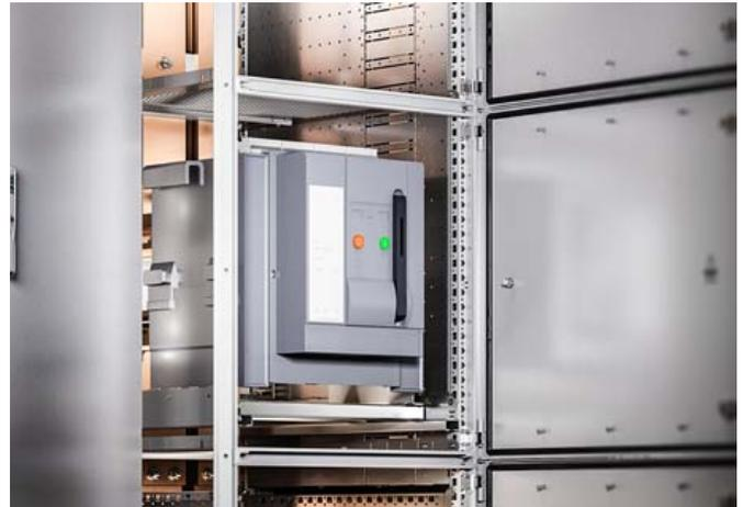
Zusätzlich zum Leistungsschalter darf in das Koppelschalterfeld Steuerungs- und Messtechnik mit einer Verlustleistung von max. 50 W installiert werden.
