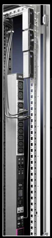
Индивидуальные датчики могут подключаться непосредственно через интерфейс CAN-Bus у PDU и далее к централизованной системе мониторинга.
