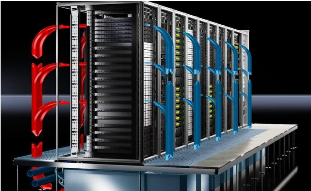
Rysunek 3. Przepływ powietrza przez moduły serwerowe
