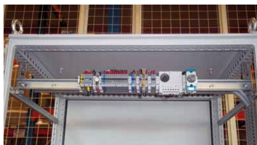
Vorverdrahtete Steuerungsleiste mit Wandlerklemme, Ventilatorthermostat, Sicherheitsthermostat und steckbaren Stufenansteuerungen
