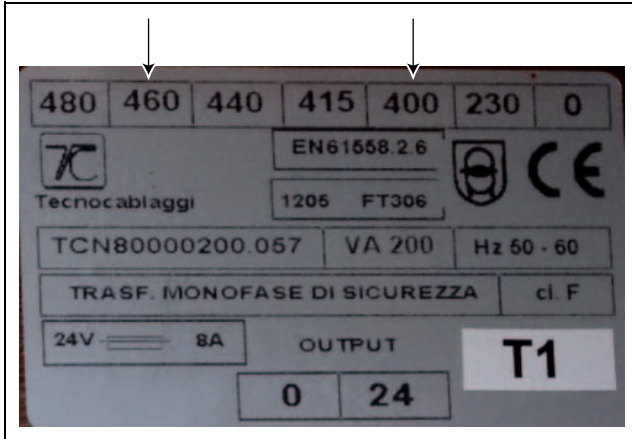
Imagen 21: Conexión transformador
