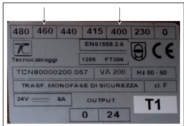
Fig. 9 : raccordement du transformateur
