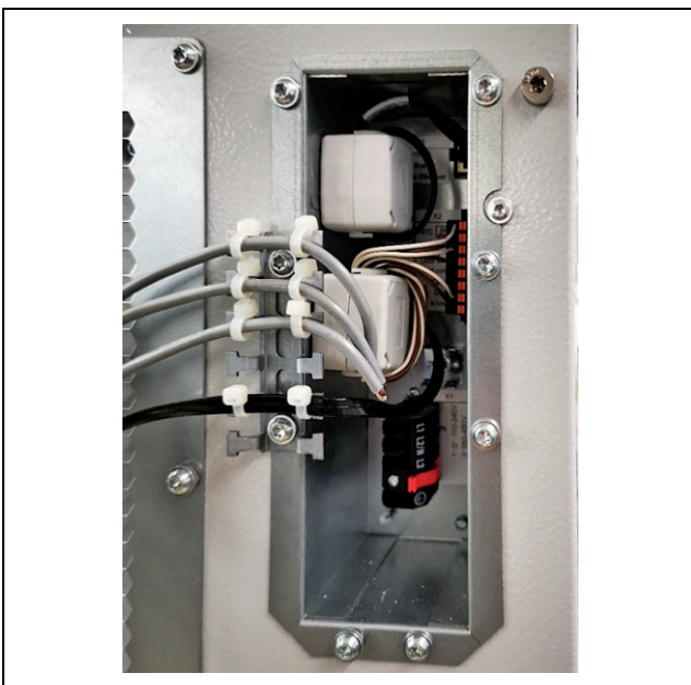
Rys. 33: Punkt montażu rdzenia ferrytowego przy SK 3186330, SK 3187330, SK 3188340, SK 3189340
