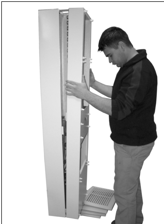
Рис. 71: Снимите кожух корпуса с крепления и немного отодвиньте в сторону
