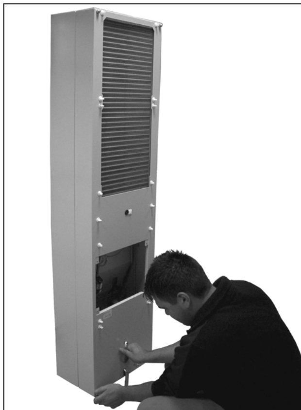
Рис. 70: Отвинтите четыре гайки, удерживающие кожух корпуса кондиционера
