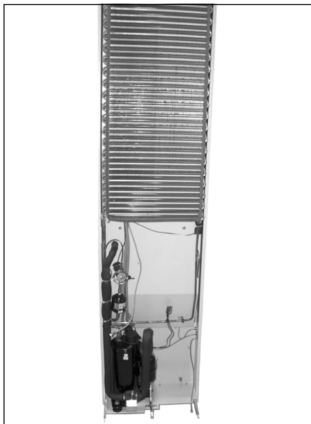
Рис. 74: Внешний вид кондиционера без кожуха корпуса
