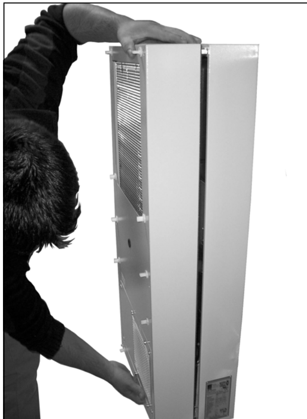
Рис. 47: Сдвиньте кожух корпуса на себя
