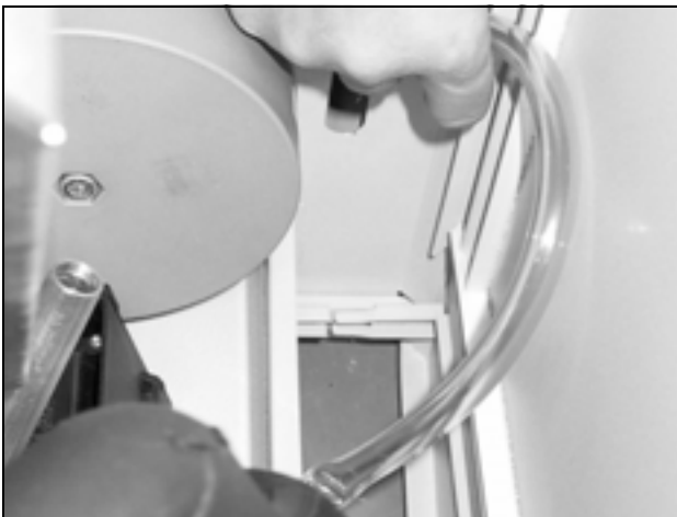
Fig. 9: Estrazione del tubo di scarico della condensa
