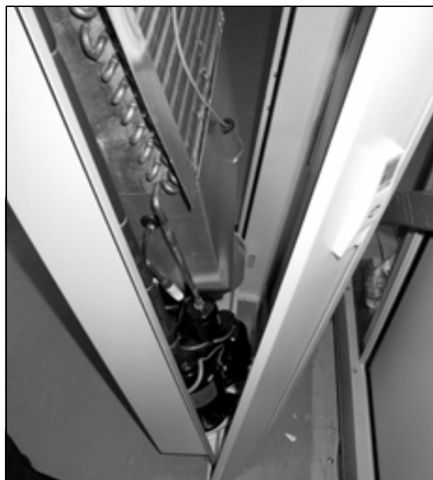
Fig. 8: Montaggio dell'unità clima nel carter porta
