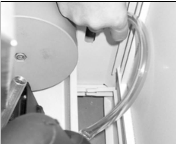
Afb. 9: Condensafvoer uit het aggregaat voeren
