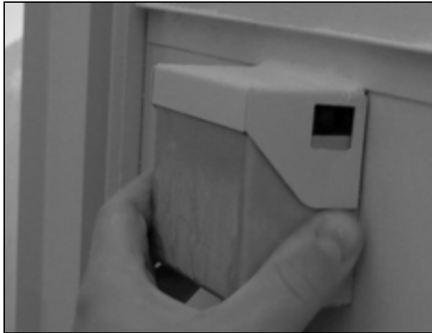
Afb. 14: Afdekkapje verwijderen
