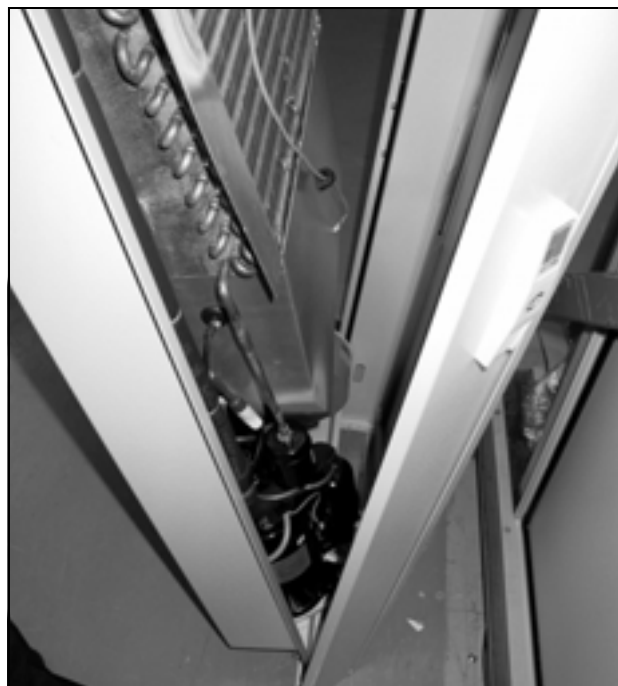
Fig. 8 : Montage du module de refroidissement dans la porte profilée
