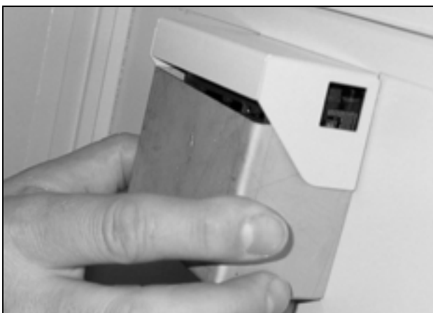
Imagen 17: Colocación de la tapa
