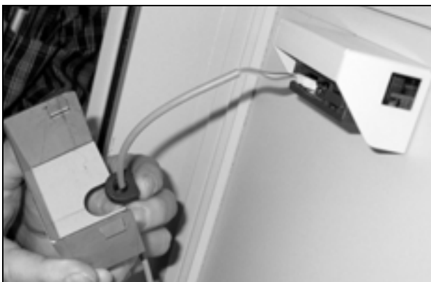
Imagen 16: Introducir la boquilla para cables
