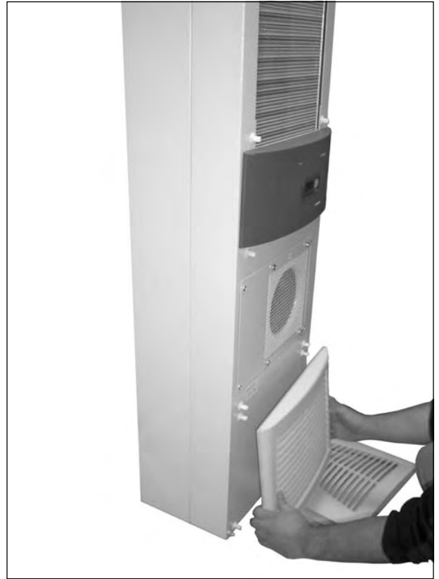
図62： 下のプラスチックルーバーを取外す(2)
