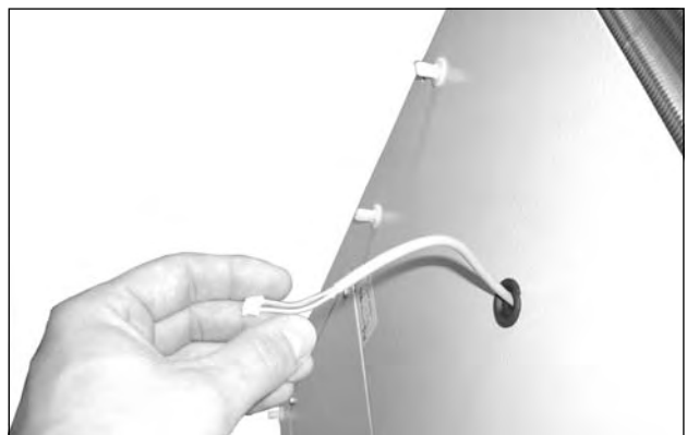
図49： モニターケーブルを押し戻す
