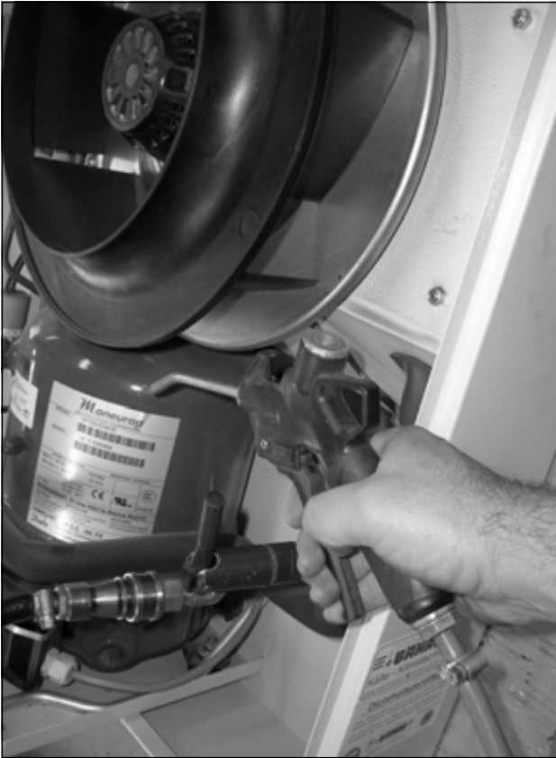
図56: ヒートエクスチェンジャー部分とコンプレッサールームの汚れを圧縮空気で吹き払う (2)
