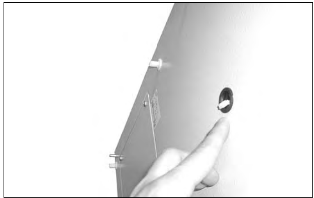
図50： モニターケーブルをケーブルの引込み口に押し込む
