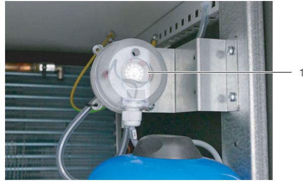
Abb. 65: Einstellschraube am Differenzdrucksensor
