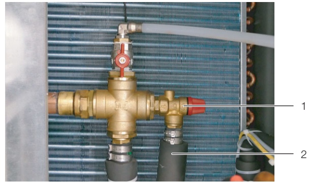
Abb. 24: Sicherheitsventil auf der Rückseite
