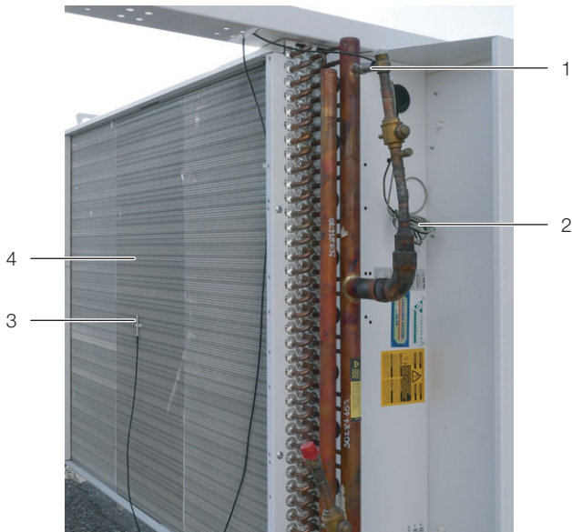
Abb. 29: Anschluss der Sensoren
