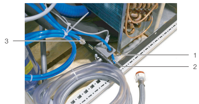
Abb. 64: Anschlüsse der Kondensatpumpe
