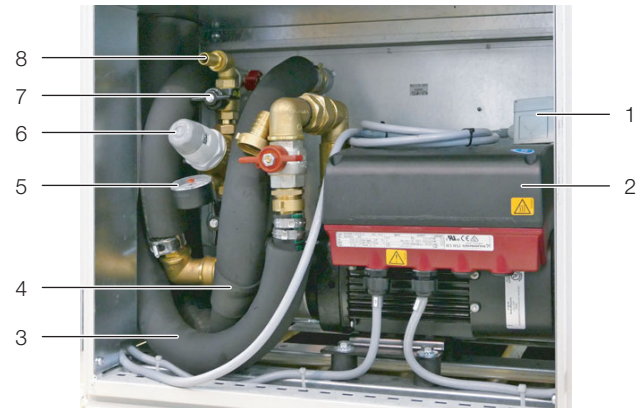
Abb. 6: Wasserkreislauf – vorne unten im Gerät
