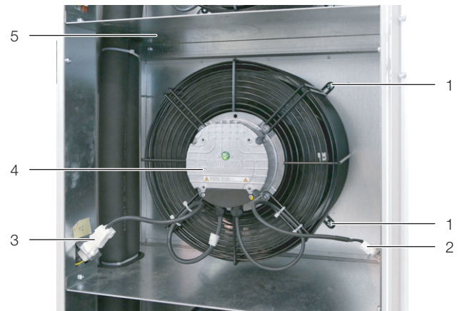
Fig. 47: Fan module
