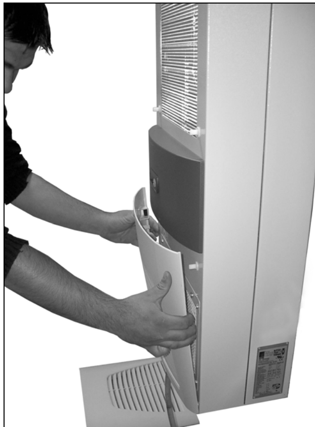
Fig. 36: Rimuovere la griglia di aerazione inferiore
