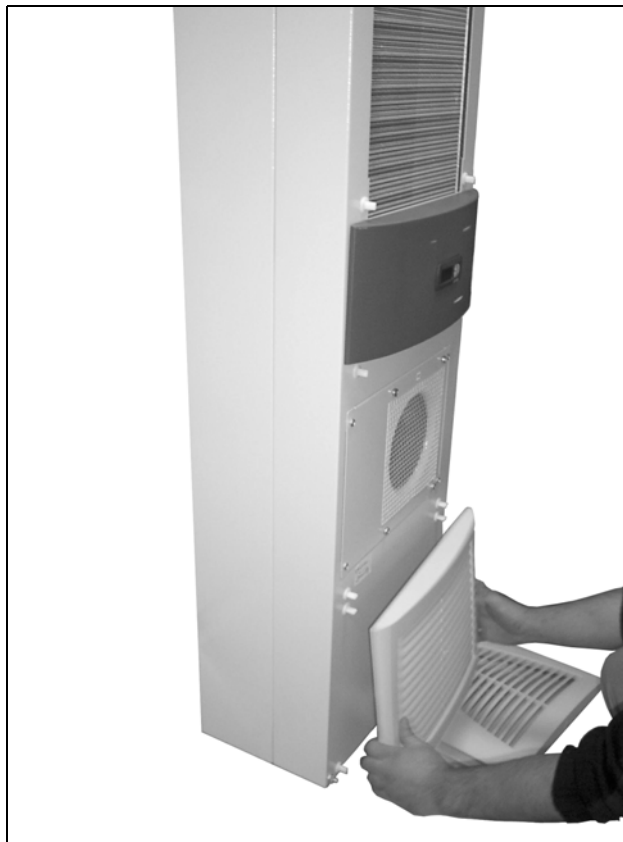
Fig. 58: Rimuovere la griglia di aerazione inferiore (2)
