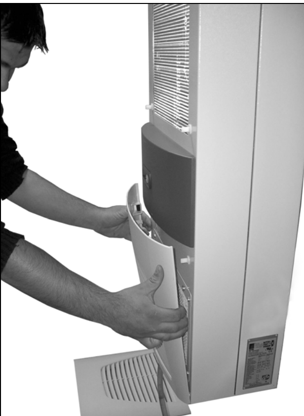
イラスト 36: 下方のプラスチックルーバーを取りのける
