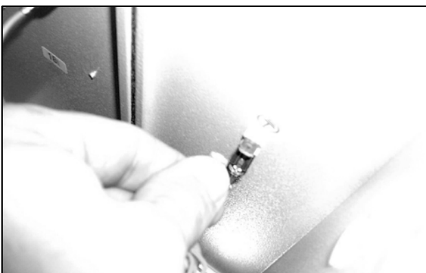
イラスト 69: ファンのアースケーブルを引き抜く (2)
