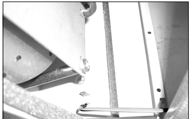
イラスト 49: カバーとシャーシ間にあるアースケーブルを引き抜く (1)
