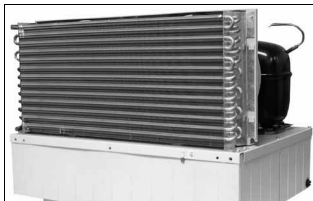
Obr. 25: Chladicí jednotka bez krytu (pohled zředu)
