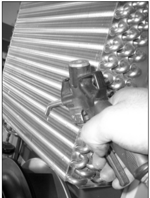
Abb. 75: Wärmetauschregister und Kompressorraum mit Druckluft ausblasen (2)
