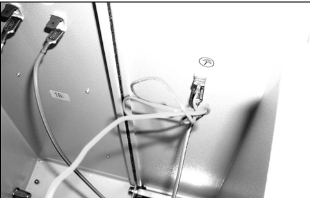
Abb. 68: Erdungskabel des Lüfters abziehen (1)
