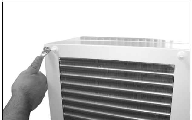
Abb. 44: Haube demontieren (vier Muttern lösen)
