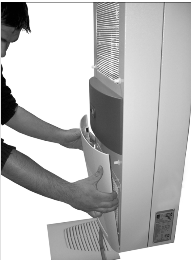
Abb. 36: Unteres Lamellengitter entfernen
