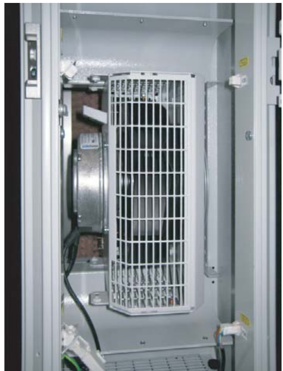
Fig. 33: Rotated fan module in fan tray – LCP Inline flush version
