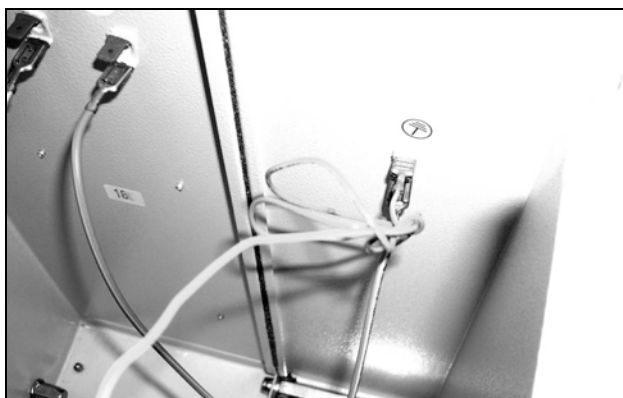
Obr. 68: Odpojení uzemňovacího kabelu ventilátoru (1)
