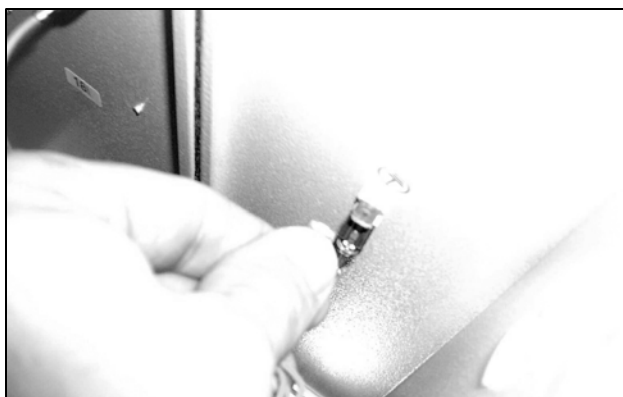
Obr. 69: Odpojení uzemňovacího kabelu ventilátoru (2)
