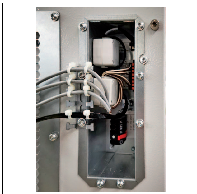
Fig. 33 : point de montage du noyau en ferrite pour climatiseurs SK 3186330, SK 3187330, SK 3188340, SK 3189340
