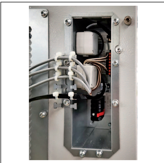
Afb. 33: Montagepunt van de ferrietkernen bij SK 3186330, SK 3187330, SK 3188340, SK 3189340
