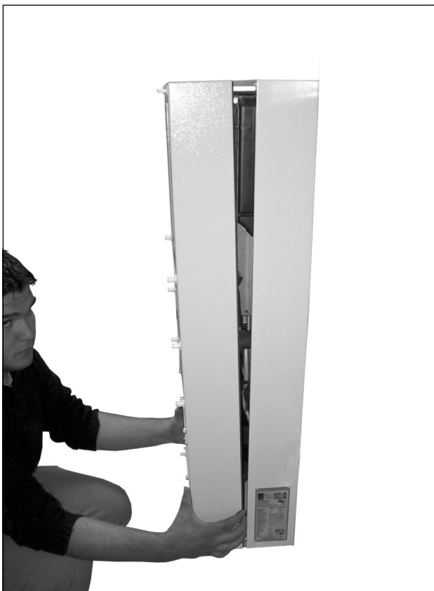
Fig. 55: Asportare la cuffia di copertura (2)
