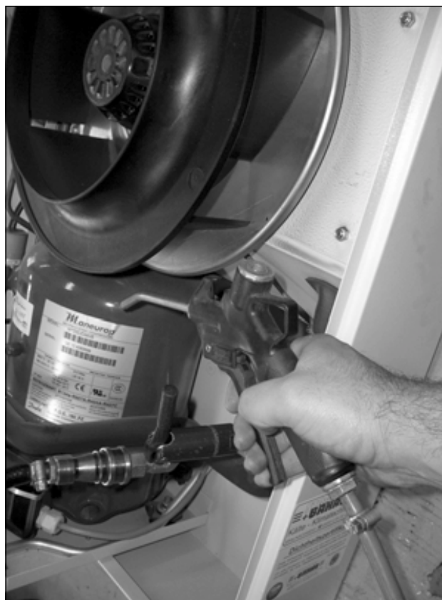
Fig. 83: Soffiare aria compressa sui tubi dello scambiatore di calore e nel vano compressore (3)
