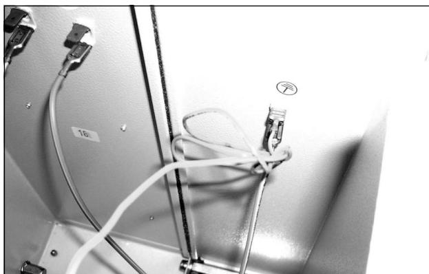
Fig. 75: Staccare il cavo di massa del ventilatore (1)
