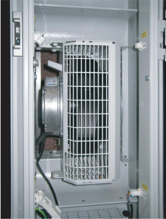
Fig. 41: Rotated fan module in fan tray
