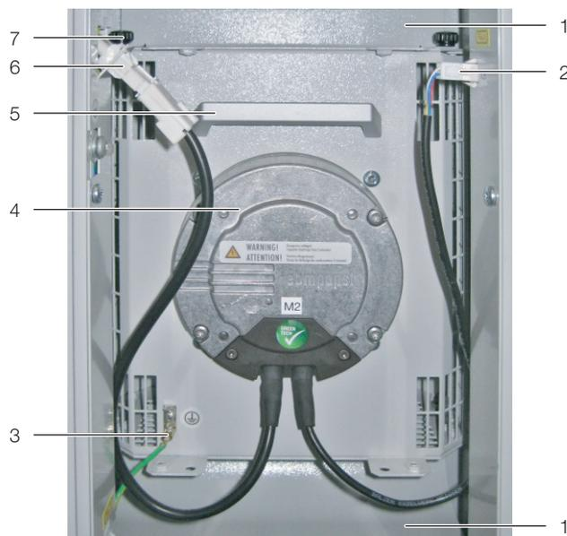
Fig. 11: Fan module in fan tray
